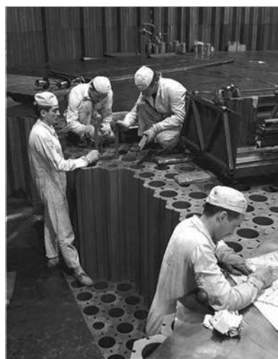
Figure 17. Mise en place des empilements de graphite lors de la construction d'une centrale UNGG. (source : EDF)
