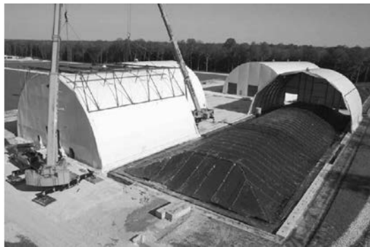
Figure 7. Fermeture d'alvéole et déplacement de la toiture mobile.
