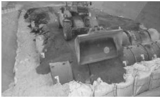
Figure 11. Béton recyclé ou GNT dans les vides.
