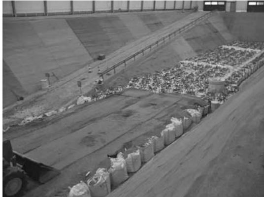
Figure 6. Stockage des déchets TFA.
